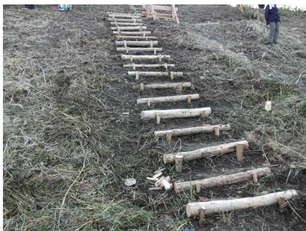
▲5つの階段が完成しました
